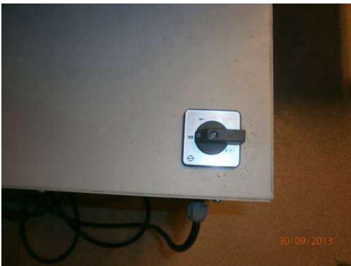
Commande d'allumage centralisée pour éviter les oublis ponctuels par zone
